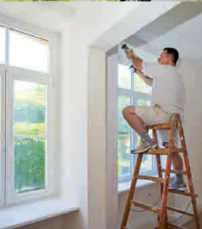
Ein denkmalgeschütztes Gebäude in der Kellerstraße nach der Sanierung und Handwerker im Einsatz
