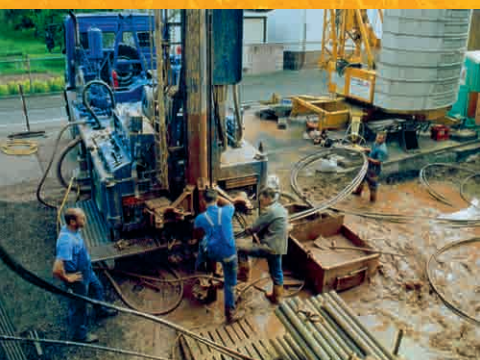
Erdbohrung für eine Erdwärmepumpe in Breckenheim
